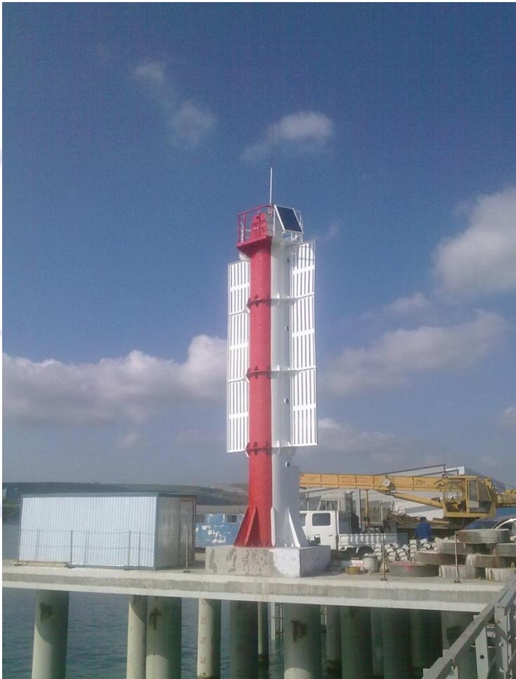
Береговой навигационный знак(створный знак) – средство навигационного оборудования побережья, башенного типа, контрастного цвета, предназначенное для сопоставления наблюдаемой судоводителем картины с определённым местом на географической карте. Используется для определения положения судна относительно оси судоводного фарватера.
